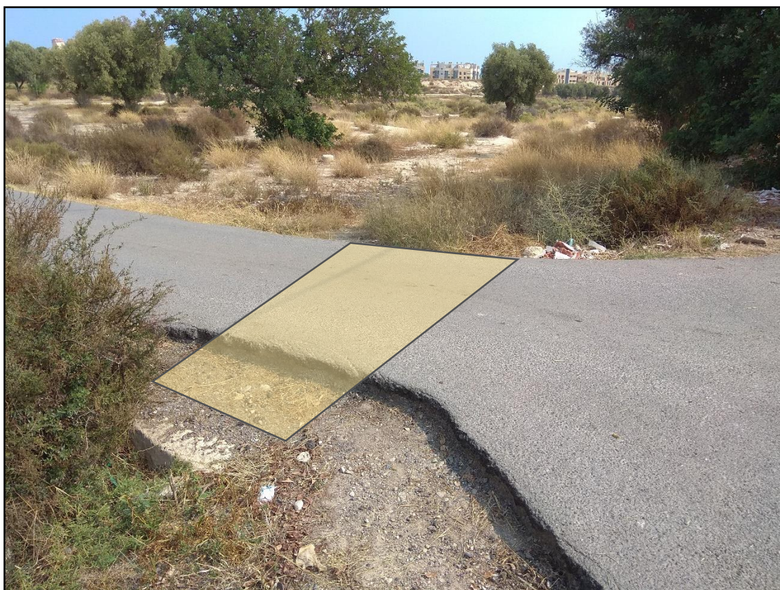
Fig. 15 – Imagen del puente de piedra que salva el Brazal del Sal a tu paso por el cruce de cuatre camins en el que se aprecia el primer sillar de arenisca y que se encuentra cubierto por el asfalto. Un documento de 1860 indica que éstos debías ser reparados por el Sindicato de riegos, puesto que el camino resultaba ser más antiguo que los cauces.
