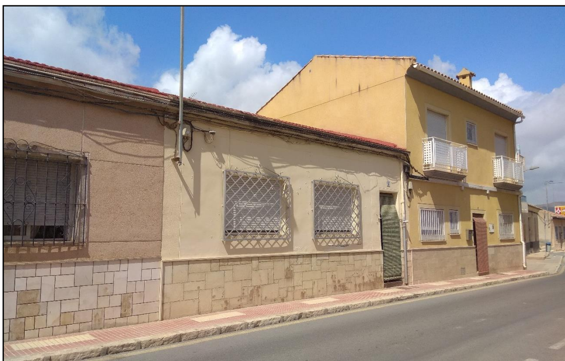
Fig. 73 y 74 – Imágenes de viviendas características de la Ley de Casas Baratas de 1911 y 1926. En la vivienda amarilla vemos como se le ha añadido una segunda planta y en la vivienda beige la puerta ha sido modificada, dejando el pasillo en un lateral.
